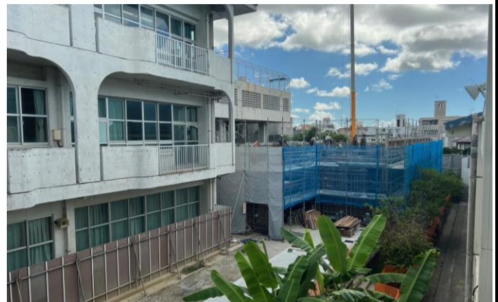
長田小学校校舎増築工事の様子(7月現在)
